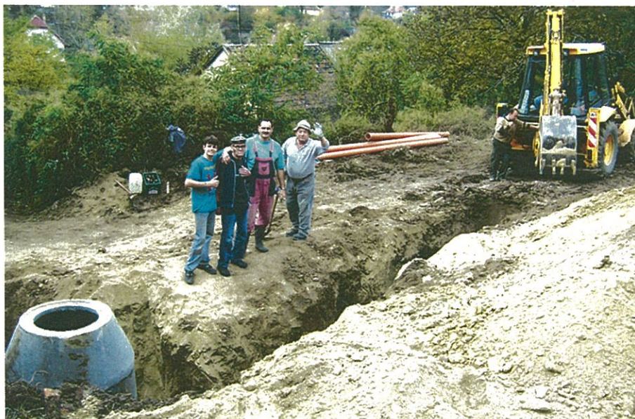
15.kép: Közüemi csatorna építése
